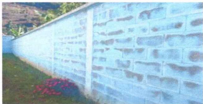
Foto 5: Se observa el deterioro de la estructura portante de la pintura en el muro modulo III
